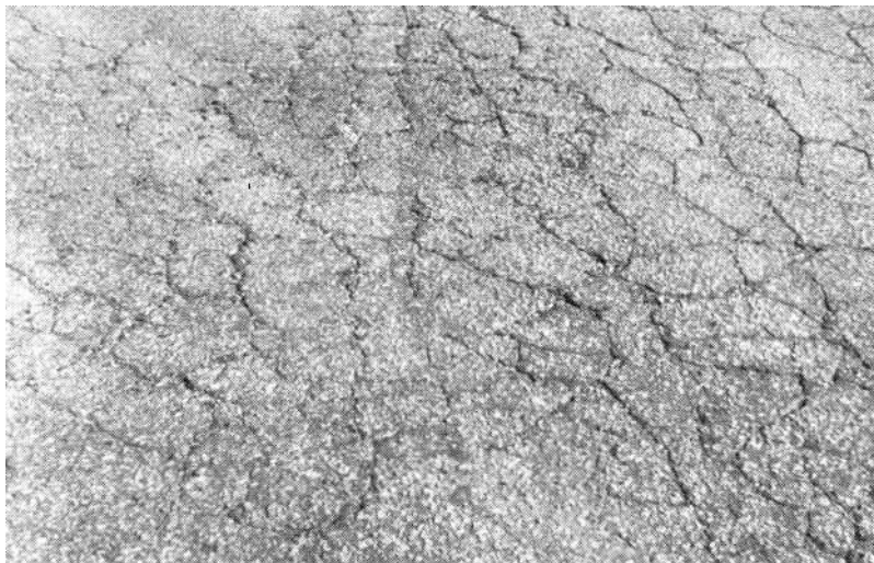
Figura 1: Tipica fessurazione da fatica
