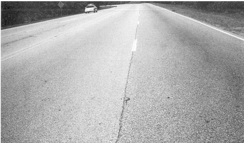
Figura 3: Fessurazioni longitudinali
