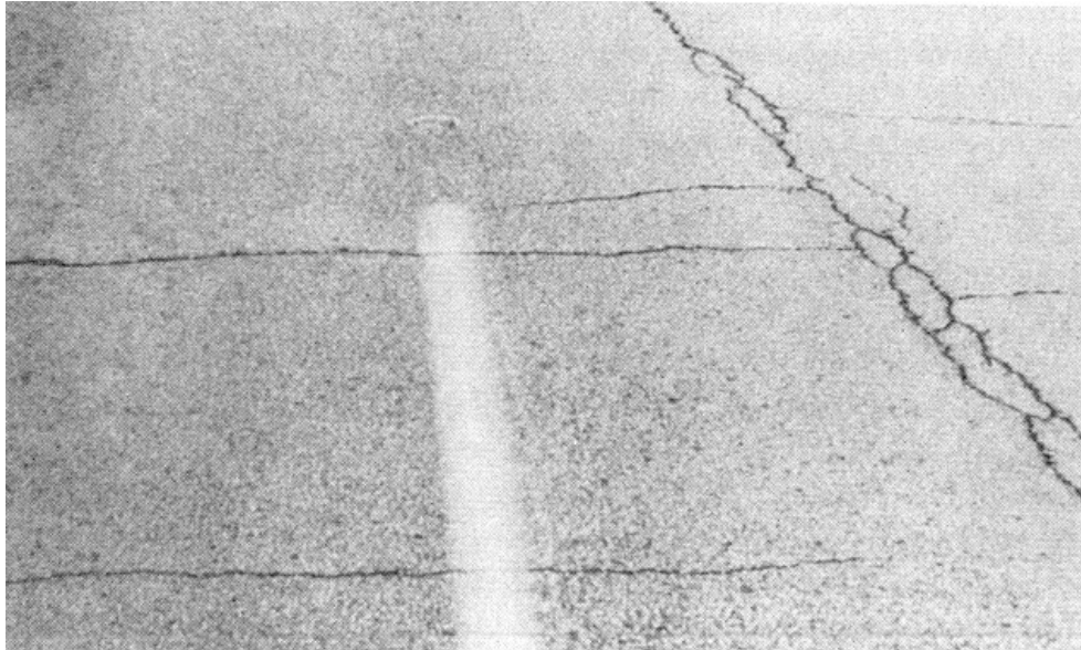
Figura 5: Fessurazioni da propagazione
