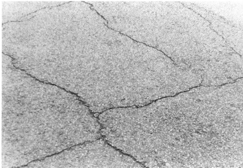
Figura 4: Fessurazioni a blocchi
