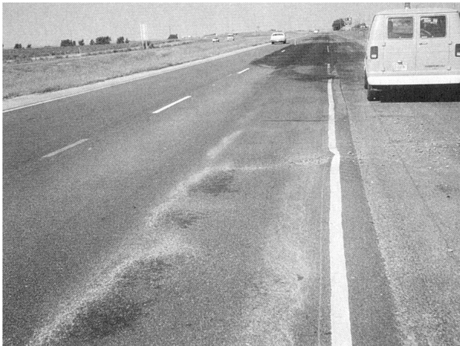
Figura 10: pavimentazione soggetta ad uno stadio ultimo di spogliamento
