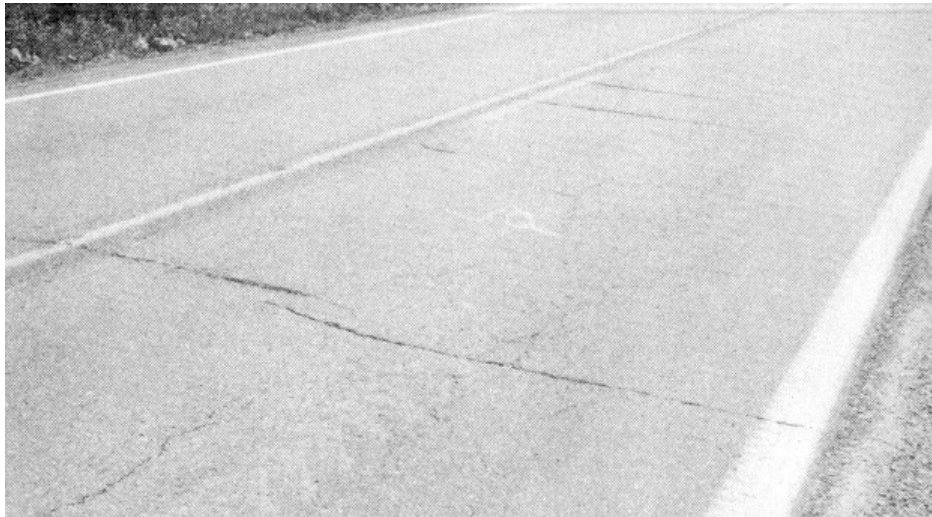
Figura 2: Fessurazioni da stress termico alle basse temperature
